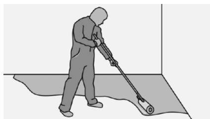
Рис. 20. Грунтование стяжки
